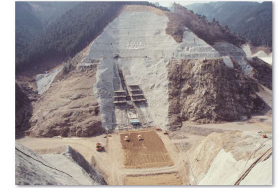
堤体盛立状況
