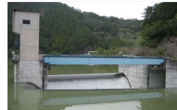
◆非常用洪水吐からの越流状況
