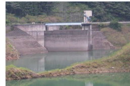
◆出水期の水位の状況(対岸より)
