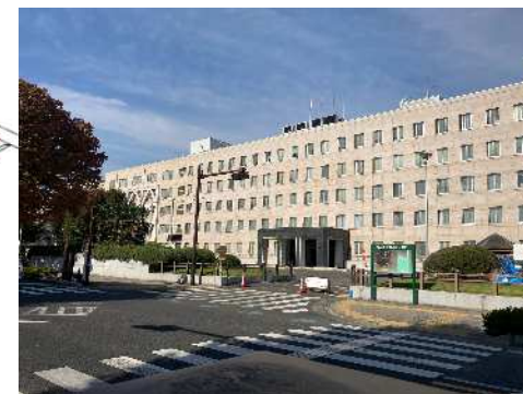
敷地南側からの本庁舎 16
