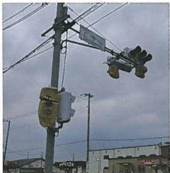
工事中の上寺山交差点信号機
