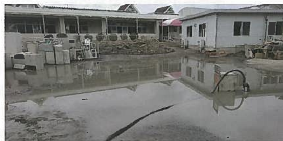
▲施設の被害状況(昨年10月)
