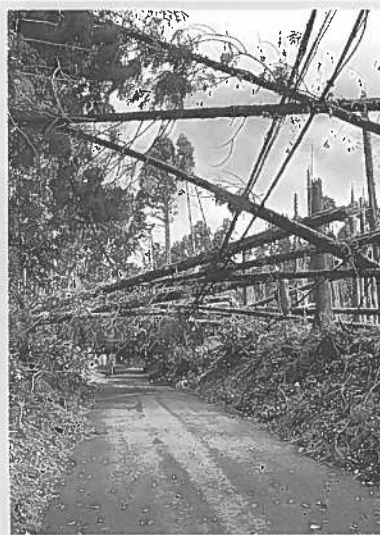
昨年の房総半島台風は倒木で電柱に被害が生じた
