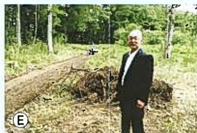
E地点、遊歩道の整備が進められています。
