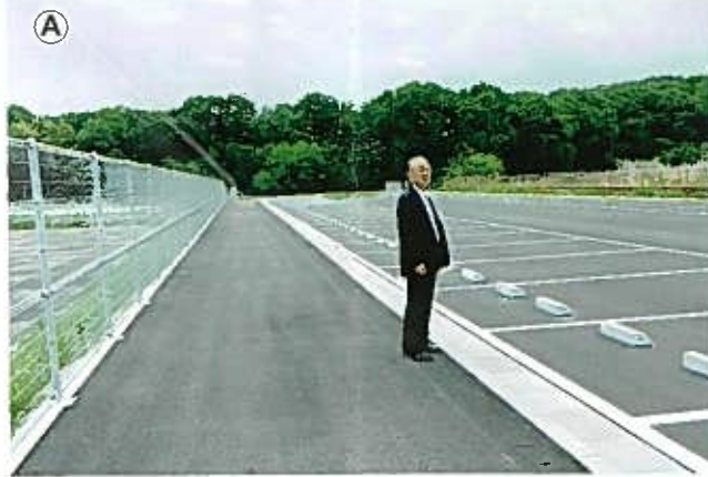
A地点から南東を望む。奥には今年度から保全事業が始まっている「太田ヶ谷緑地」が広がっています。立っているところは駐車場です。全体で500台分用意します。
