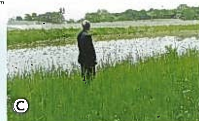
C地点から南を望む。太田ヶ谷緑地内で整備が進む遊水池、その先には調整池の整備が行われています。
