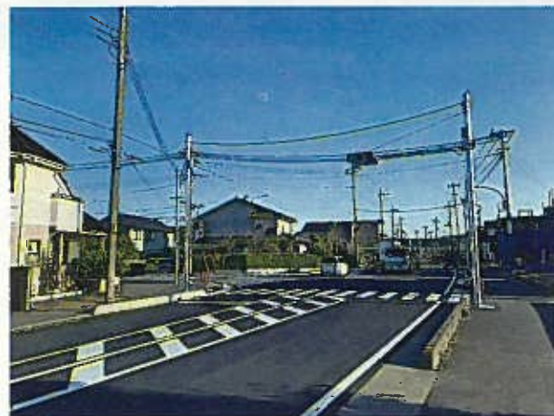
▲信号機が設置された四本木地内の交差点
