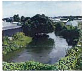
素掘(すぼり)水路・妻沼地区→
