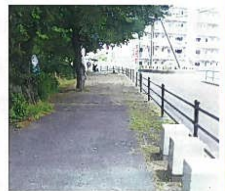
霞川団地歩道修繕
