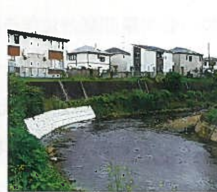
千代橋上流護岸修繕
