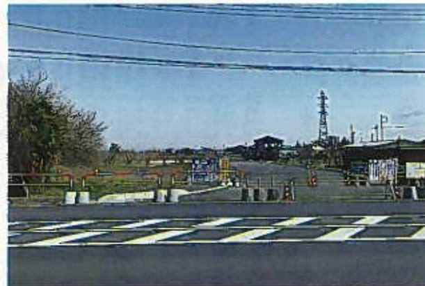
▲日高川島線(北平沢運動場南側あたり)
