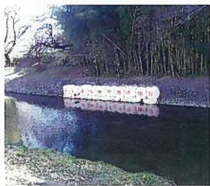
和田橋下流応急復旧護岸
