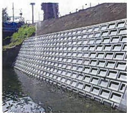
清水橋下流護岸再構築
