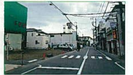
解体作業も進む東武動物公園駅前通り。
