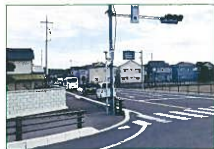
右折レーンと歩道が設置された中樞交差点
