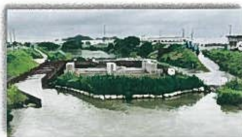
工事中の写真(2019年7月)
