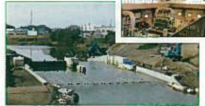
完成が見えてきた工事現場。大きな堰をつくり、水量調整を可能にします。
