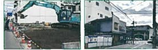
解体作業も進む東武動物公園駅前通り
