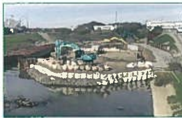
完成が見えてきた工事現場 宇和田公園上流
