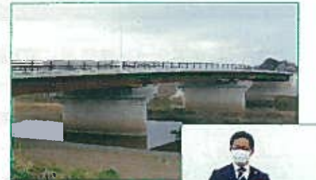
茨城県との協力で完成した新たな「令和橋」 右)開通式のテープカット
