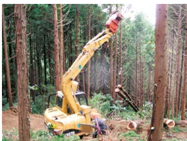
スイングヤードにより伐採された木を集める
