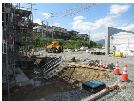
防潮堤整備の様子（大船渡市）
