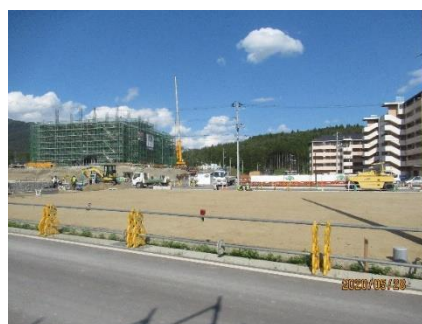
被災した庁舎の建替え（陸前高田市）
