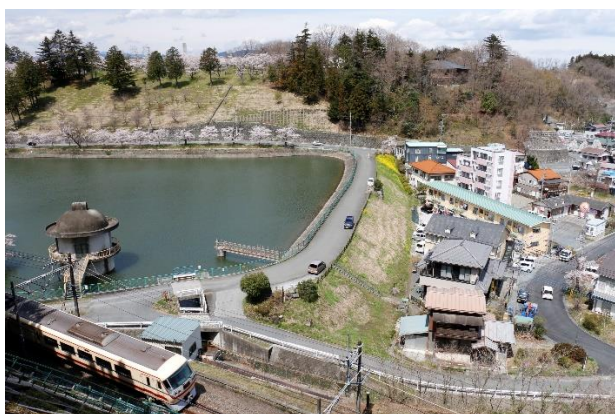
堤体の下流に住宅や道路が近接するため池（姿の池・横瀬町）
