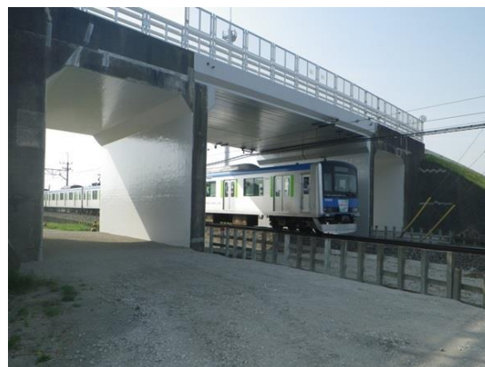
耐震性強化のため橋台を補強（9-4007号橋春日部市）
