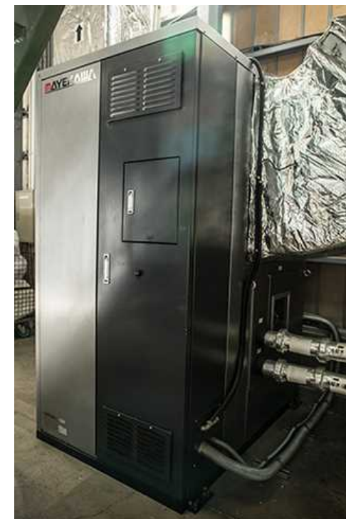
熱風ヒートポンプ 110kW×1台
