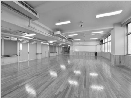
フローリング等の補修・木質化(多目的室)
