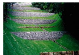
治山施設の整備
