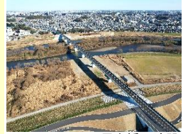
長大橋の建設
