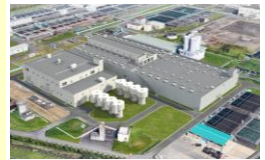
高度浄水処理施設(整備中)
