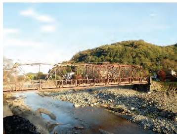
【矢岸橋歩道橋】
