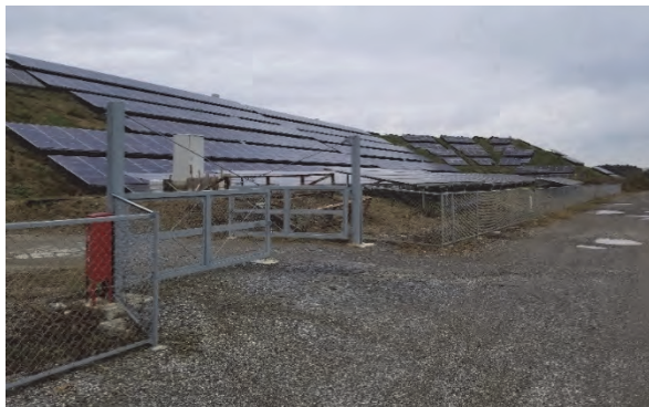
図 2-2-4 境界フェンス
