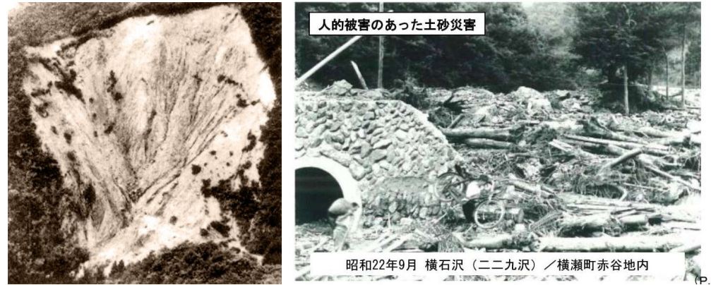
図2-7:カスリーン台風の被災状況
