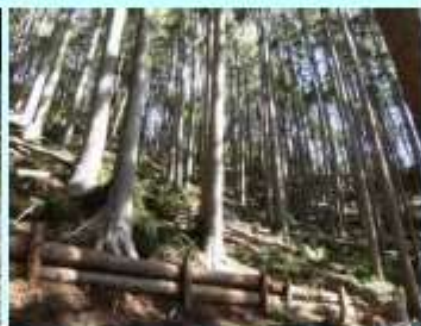
治山事業による整備
