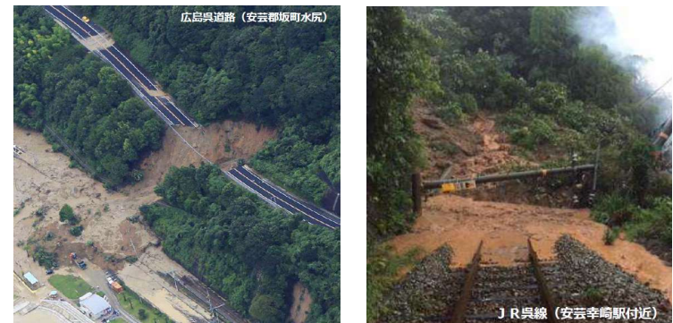
図2-12:土砂災害による国道の寸断(平成30年7月豪雨、広島県) https://www.pref.hiroshima.lg.jp/uploaded/attachment/416119.pdf
