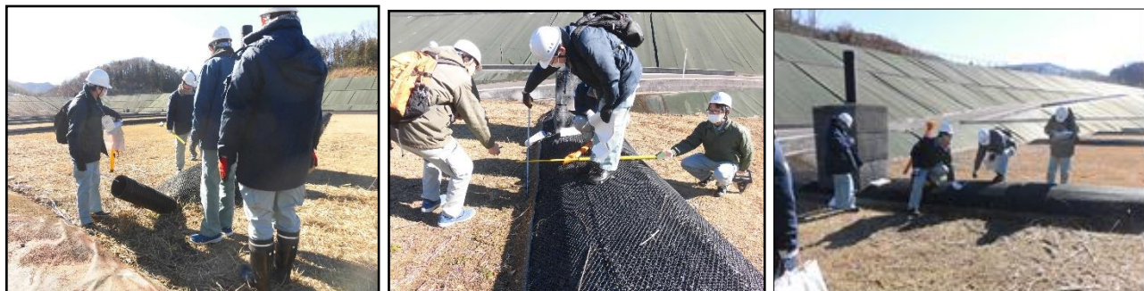
最終処分場への立入検査の様子
