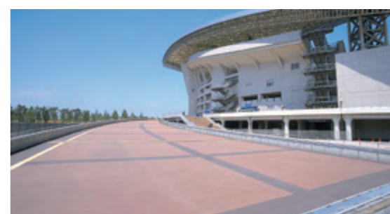
スロープ 緩やかなスロープを歩き、ペデストリアンデッキへ。老若男女、誰もが来場できるスタジアムを目指しました。 Slope You can walk on a gentle slope up to the pedestrian walkway; aiming for a stadium where everyone, young and old, can visit.
