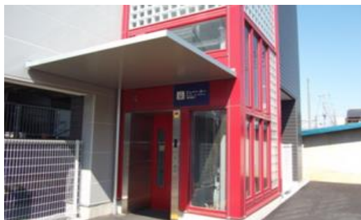
障害者対応型エレベーター
