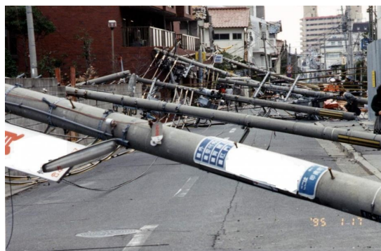
地震時の電柱倒壊（阪神淡路大震災）
