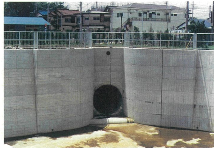
放水路（トンネル河川）香口部
