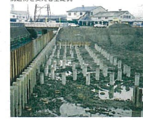
越流堤の基礎 構造物を支える基礎杭
