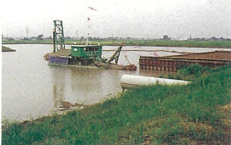
▲ 浚渫船による調節池掘削状況
