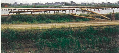
▲ 排砂管による埋立状況
