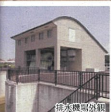
排水機場外観
