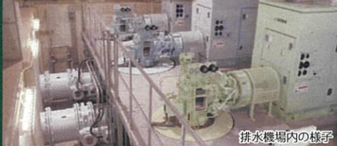
排水機場内の様子
