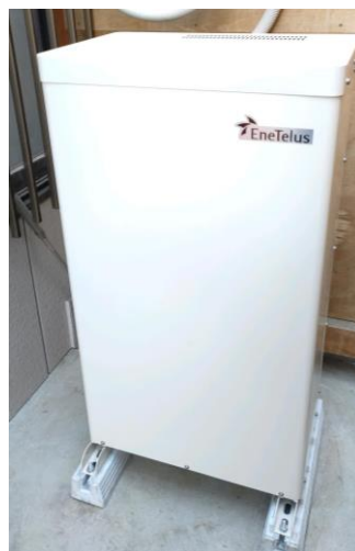
蓄電池（補助対象設備）
