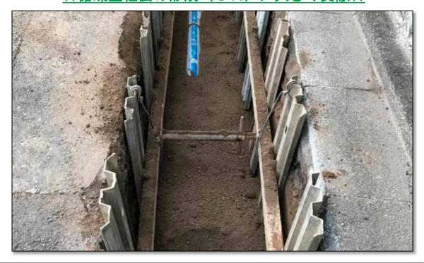
再資源化された改良土 (製品名:ユニ・ソイル)は、第2種改良土以上の強度 (品質) が確保でき、また土壌環境基準値(安全性)を満足し埋戻し材などの 土木資材としてリサイクルされます。
