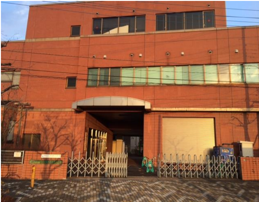
下水道公社本社外観
