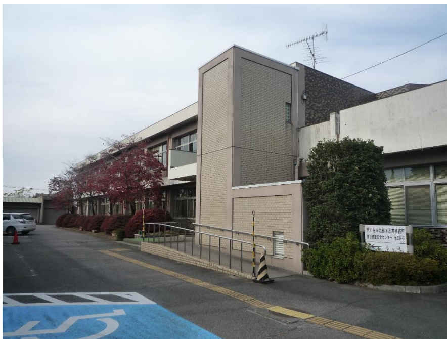
荒川左岸北部下水道事務所外観
