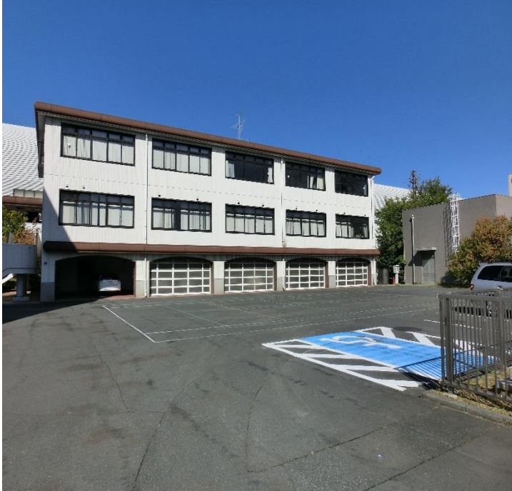
荒川左岸南部下水道事務所外観
