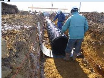
水田地帯で本格的な野菜生産が行えるよう、排水路を深くして排水効果を高め、地下水位を低下させる。
