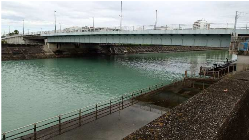
図 1-4 青潮状態の境川河口(写真右奥が上流方向)
