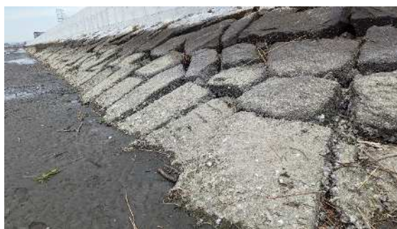
①高潮堤防礎石部分
