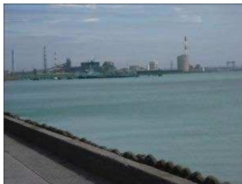
写真：千葉港（平成23年8月30日）
