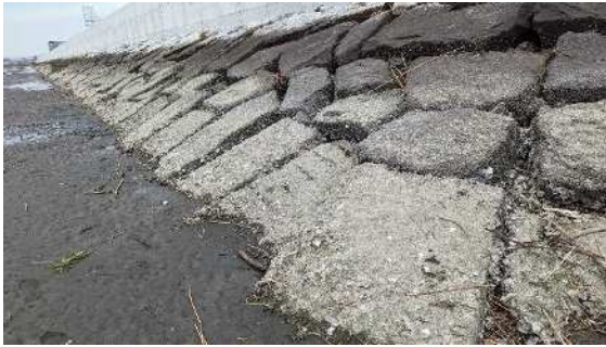
①高潮堤防礎石部分
