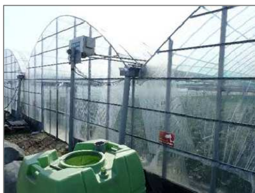
防犯カメラの設置
