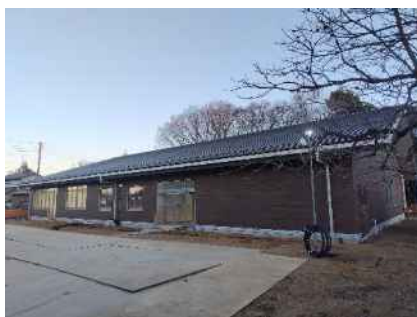
（建設中の環境学習館）
