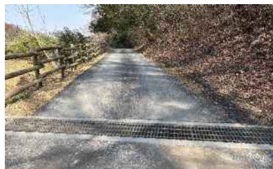
（事業2：進入路の舗装状況）
