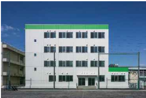
（増築校舎外観）
