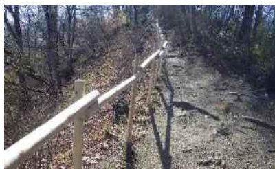
（事業2：木柵の設置状況）
