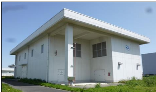
【自家用発電機棟】
