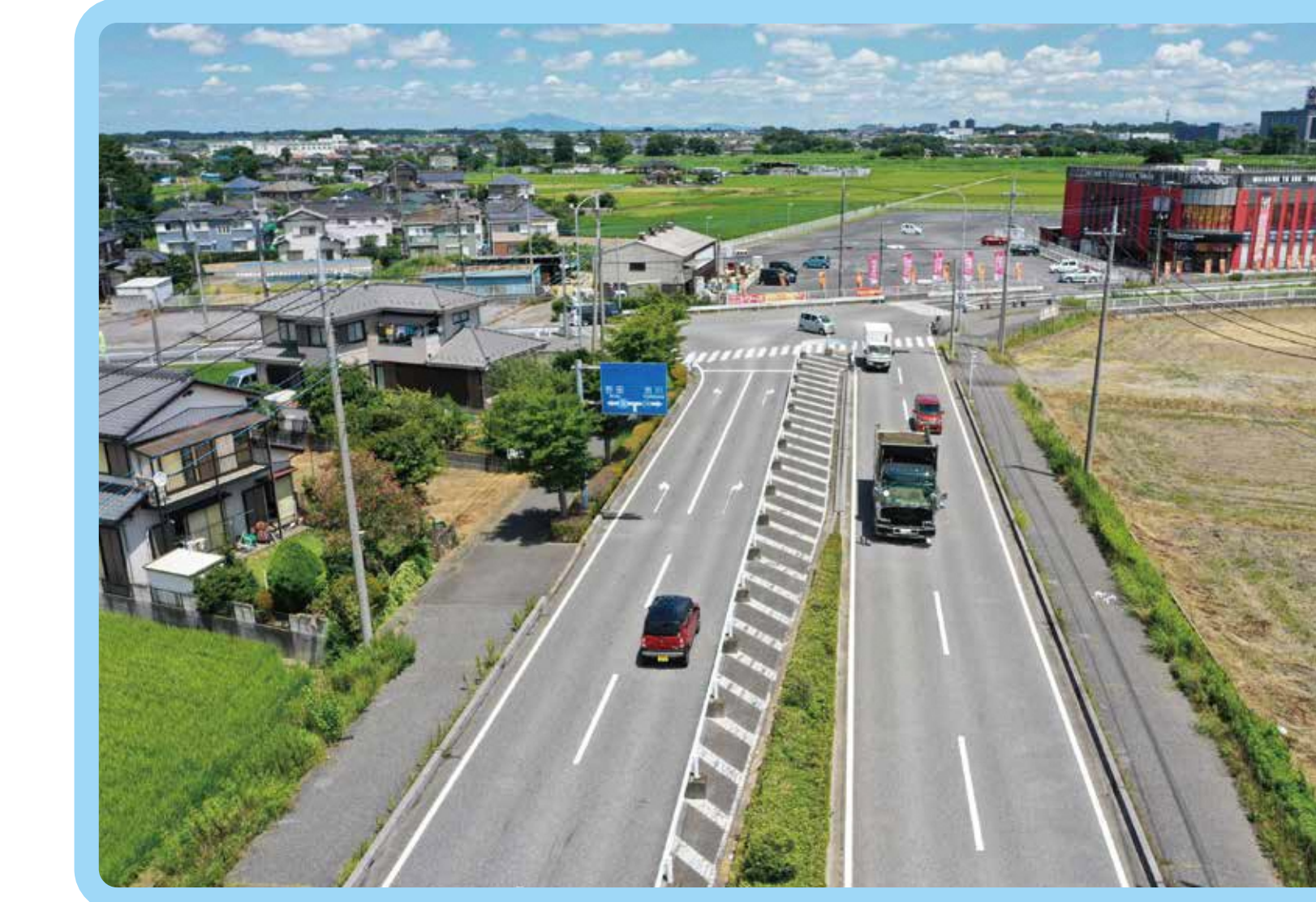
6 松伏町田島地内 (県道中井松伏線交差点付近)
