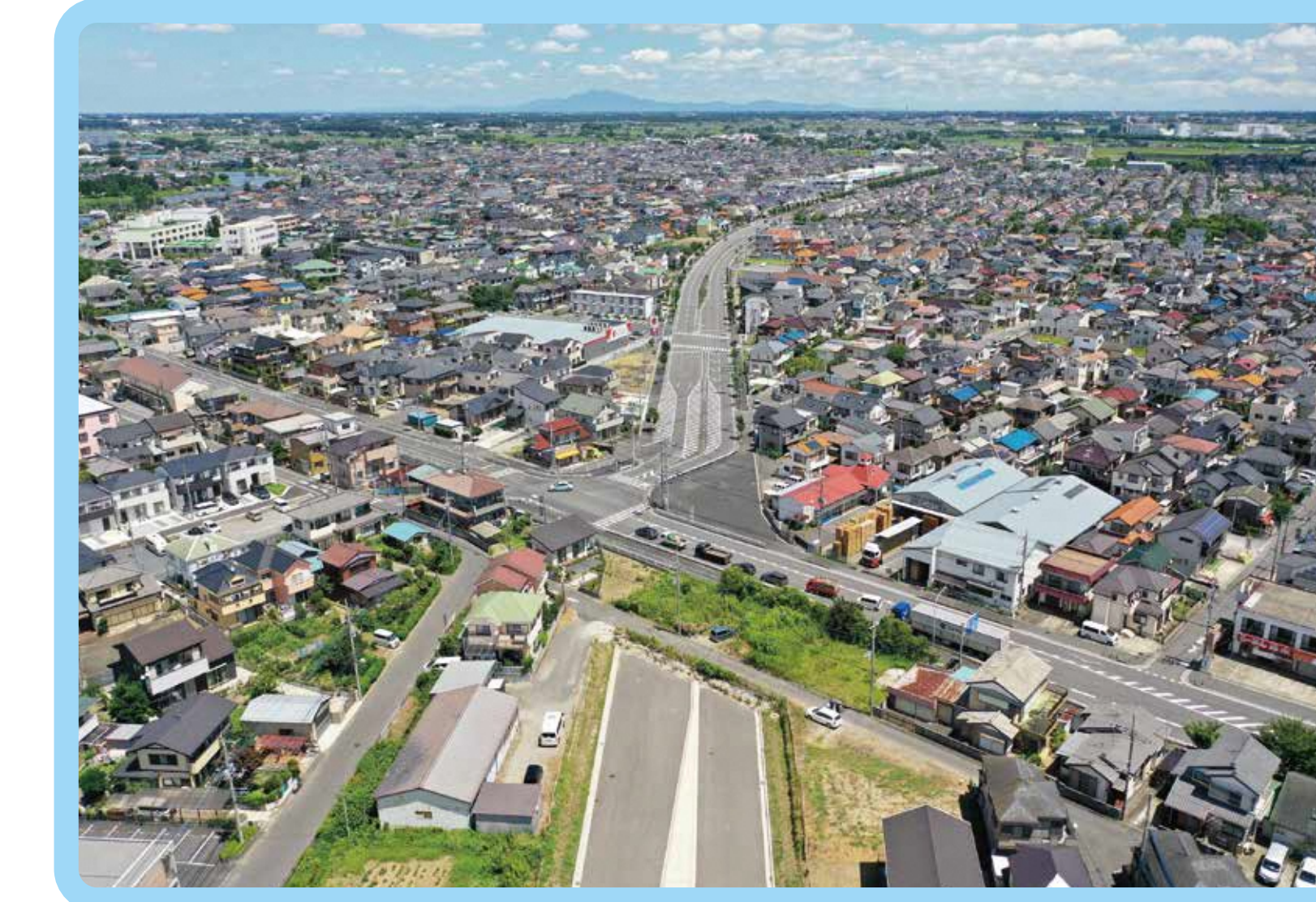
5 松伏町松伏地内 (主要地方道葛飾吉川松伏線交差点付近)
