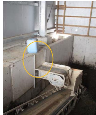
集糞ベルト搬出口のシャッター設置
