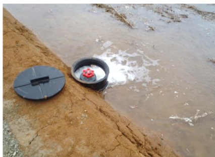
パイプラインによる用水供給
