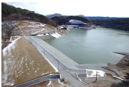
工事完了後の藤沼湖(H29.3月)
