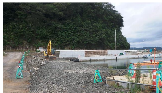
七ヶ浜町 船たまり 施工中
