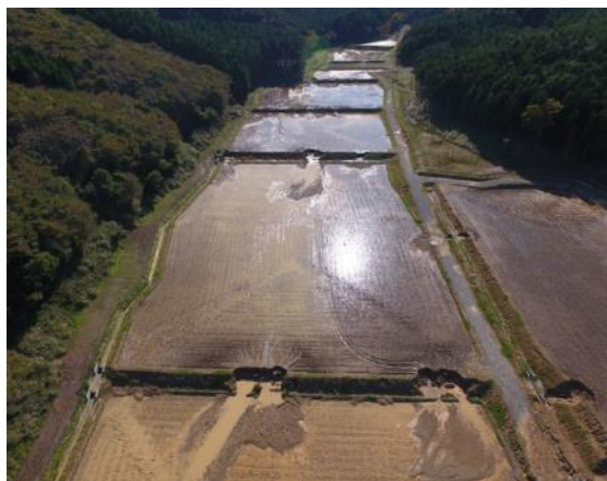
整備したほ場の令和元年台風19号被災状況
