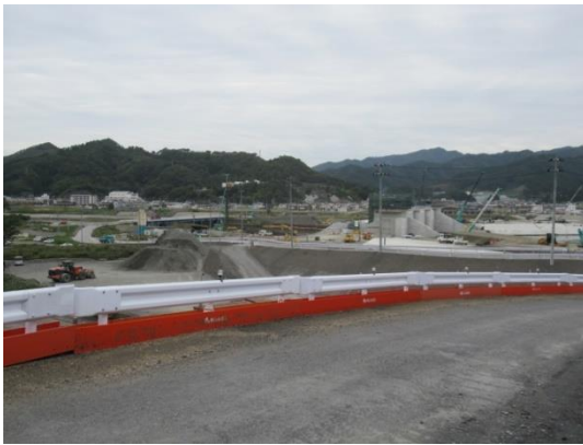
水門整備と道路かさ上げの様子（大槌町）
