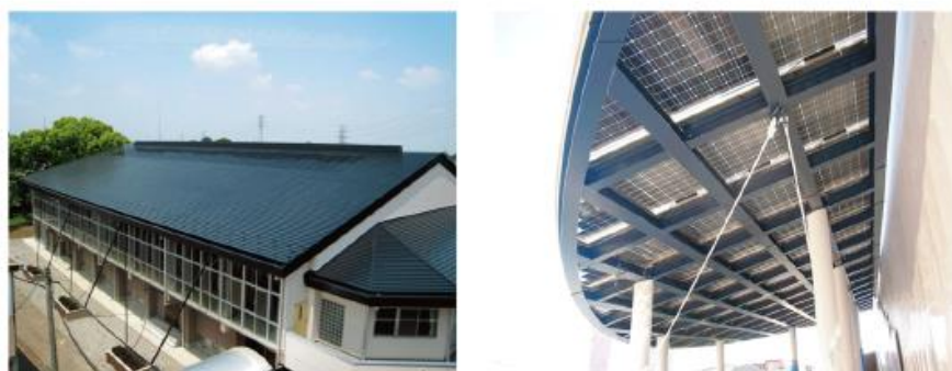
図5 建物一体型太陽光発電システム 例
