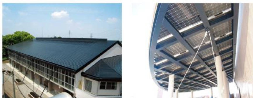
図5 建物一体型太陽光発電システム 例
