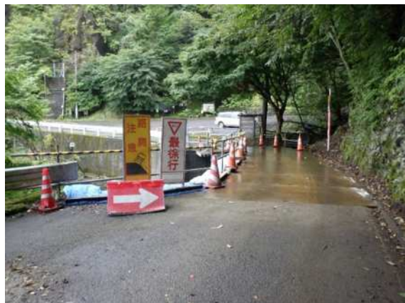
応急復旧工事完了（R4.9.15）
