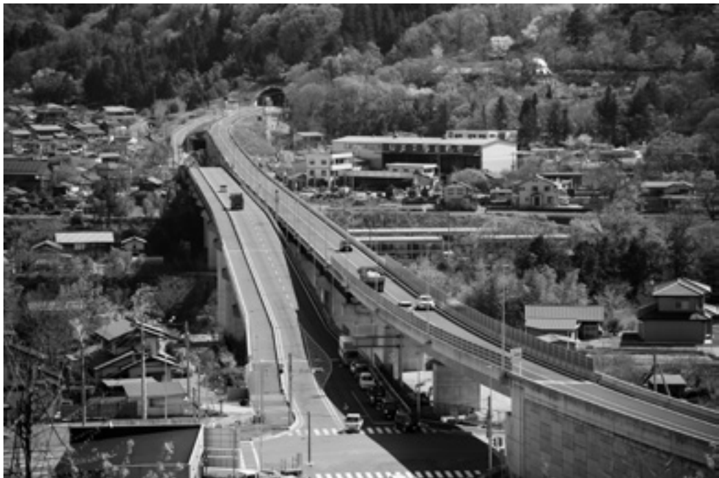
地域高規格道路 (国道 140 号皆野秩父バイパス)
