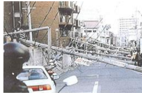
阪神淡路大震災における電柱、建物等の倒壊状況
