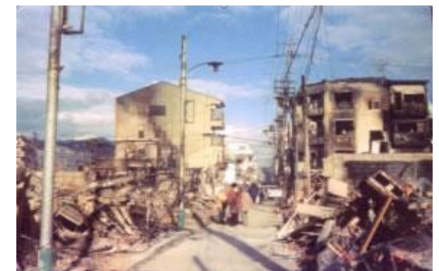
出典：国土交通省HP(道路防災の取組み)
