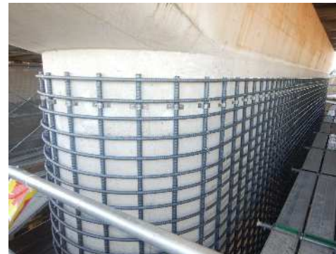
いろは橋の耐震補強
