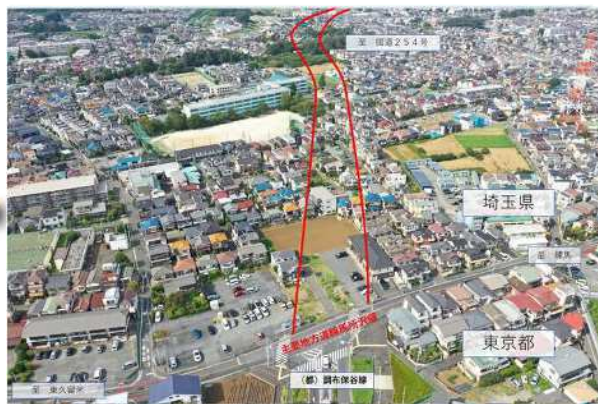
野寺工区：都県境から北側を望む
