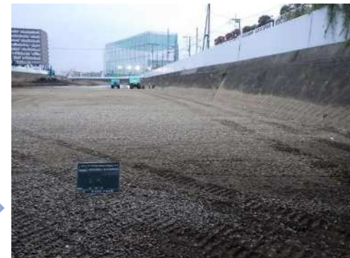
堆積土砂撤去
