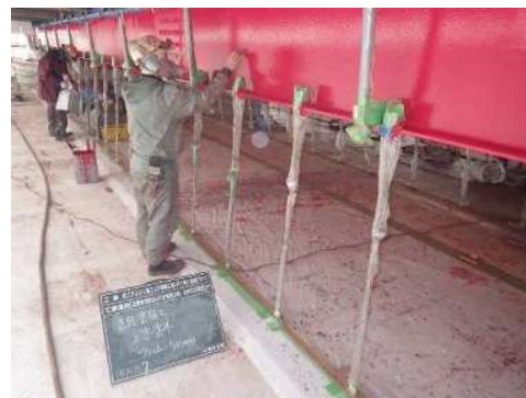
主桁の塗装塗替
