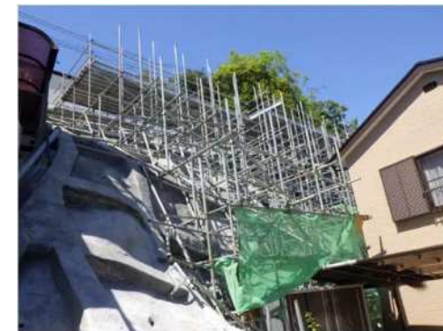
対策工事状況（和光市）
