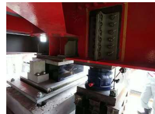
ゴム支承への交換
