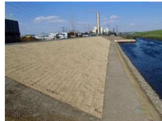
築堤・河道拡幅（整備後）
