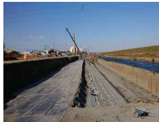
築堤・河道拡幅（整備中）
