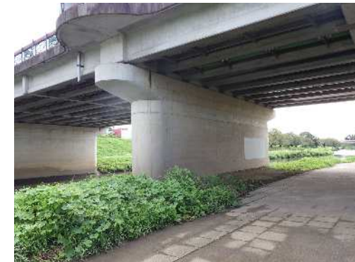
いろは橋の耐震補強
