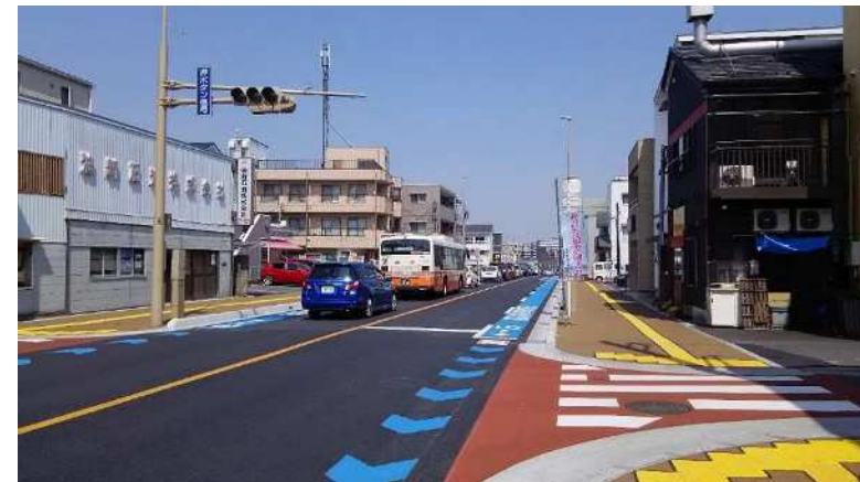
整備済みの中央通停車場線（2工区）
