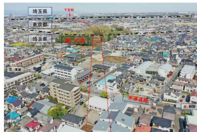
新堀工区：南側から北側を望む
